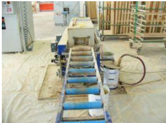
20. kép: Impregnáló berendezés
