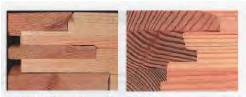
41. ábra. Csapos és kontraprofilos ablak sarokkötés
