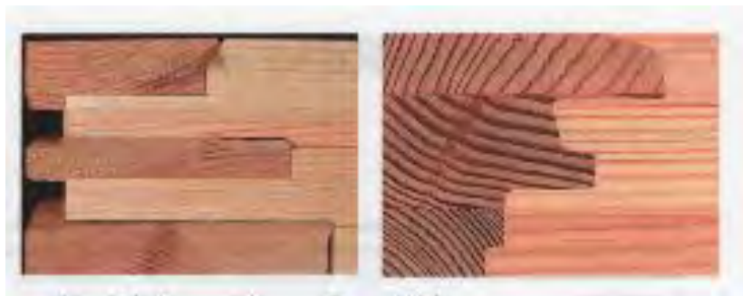
41. ábra. Csapos és kontraprofilos ablak sarokkötés
